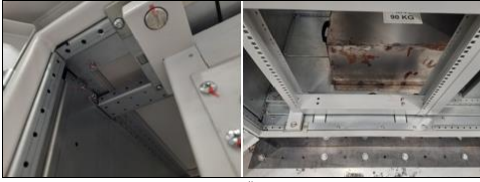
Resim 5. Kapı Bağlantı Detayları
